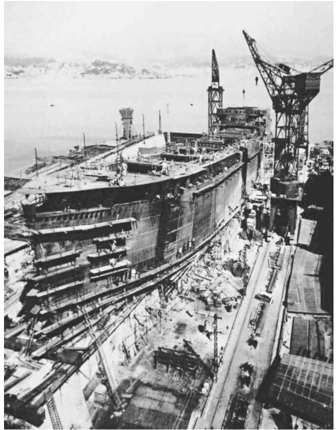
Bateau en construction
