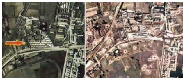
Photographie aérienne du site en 1943 et fin 1944, notez les cratères provoqués par les bombes des bombardements de Toulon. IGN
